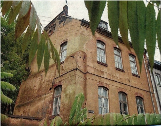
Die Renovierungsarbeiten am zukünftigen Schillingmuseum haben begonnen.
