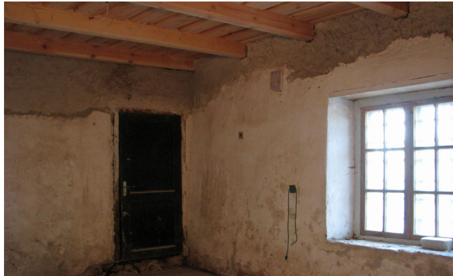
Im Innenraum wartet noch viel Arbeit
