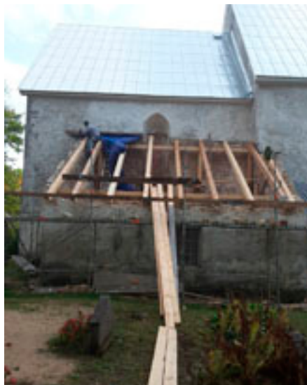
Neue Dachbalken der Sakristei
