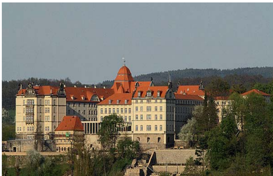
Schloss Sonnenstein nach Abschluss der Sanierungsarbeiten
